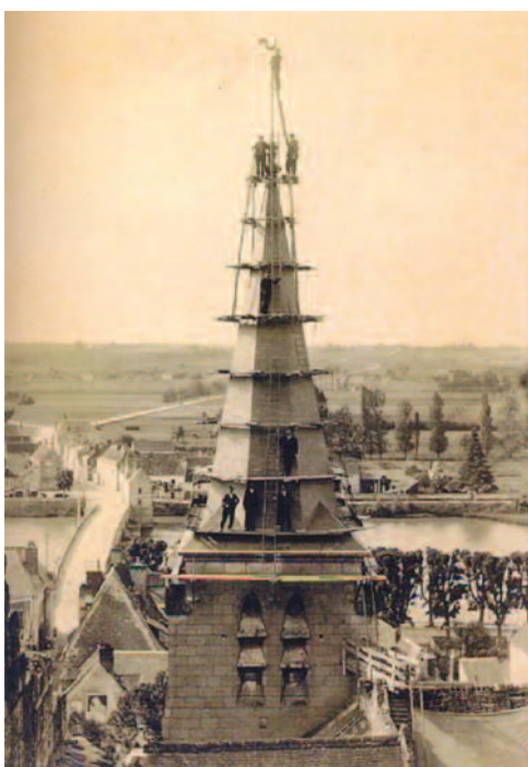
Lavoro di copertura del campanile della chiesa di Montrichard (Loire-et-cher) da parte di compagni (circa 1930)
